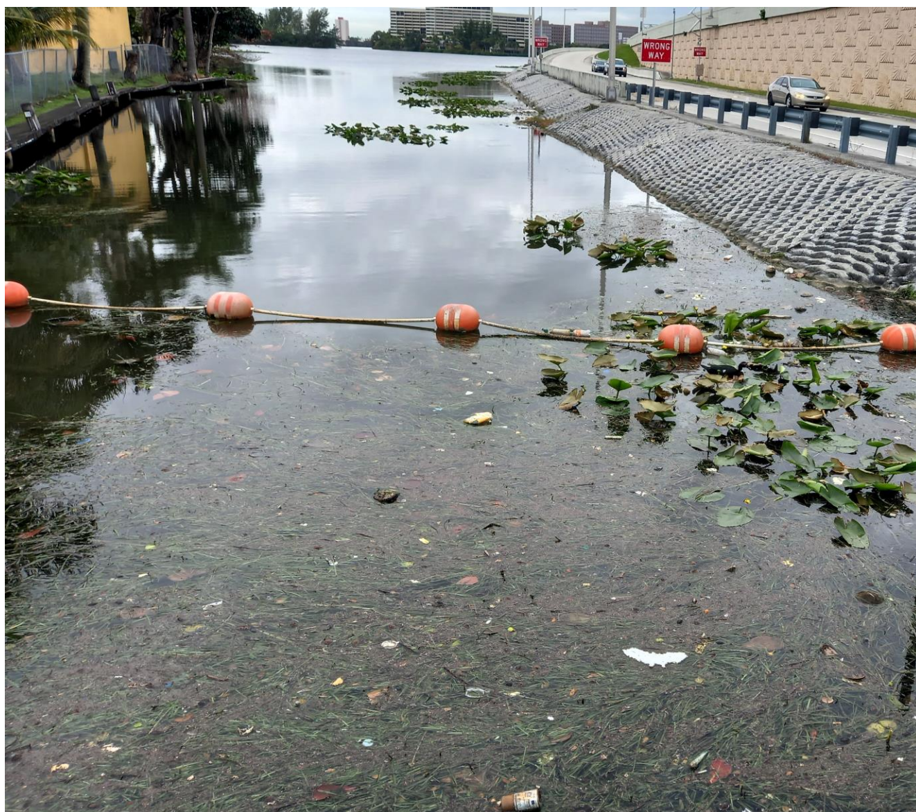
Рисунок 6.1. Задержание ВВР пластиковых фрагментов, поступающих в Голубую Лагуну (Blue Lagoon, Флорида, США) с урбанизированной территории во время торнадо
