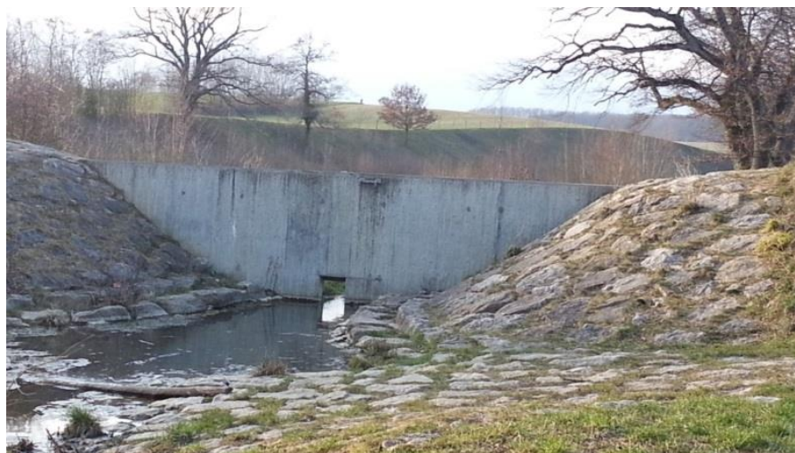
Рисунок 4.2. Одноцелевая противопаводковая плотина, Швейцария
