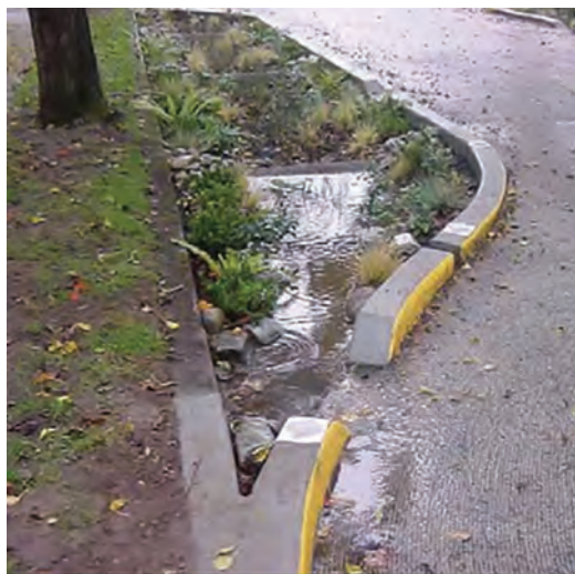
Рис. 1.42. Специально спроектированный кювет автодороги с элементами ландшафтного дизайна, перехватывающий и очищающий поверхностный сток (г. Портленд, штат Орегон)
